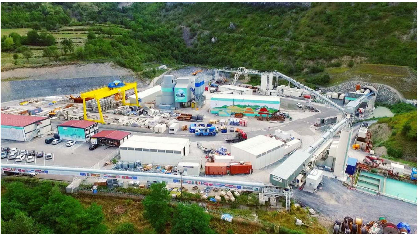
Chantier / cantiere Saint-Martin-La-Porte
