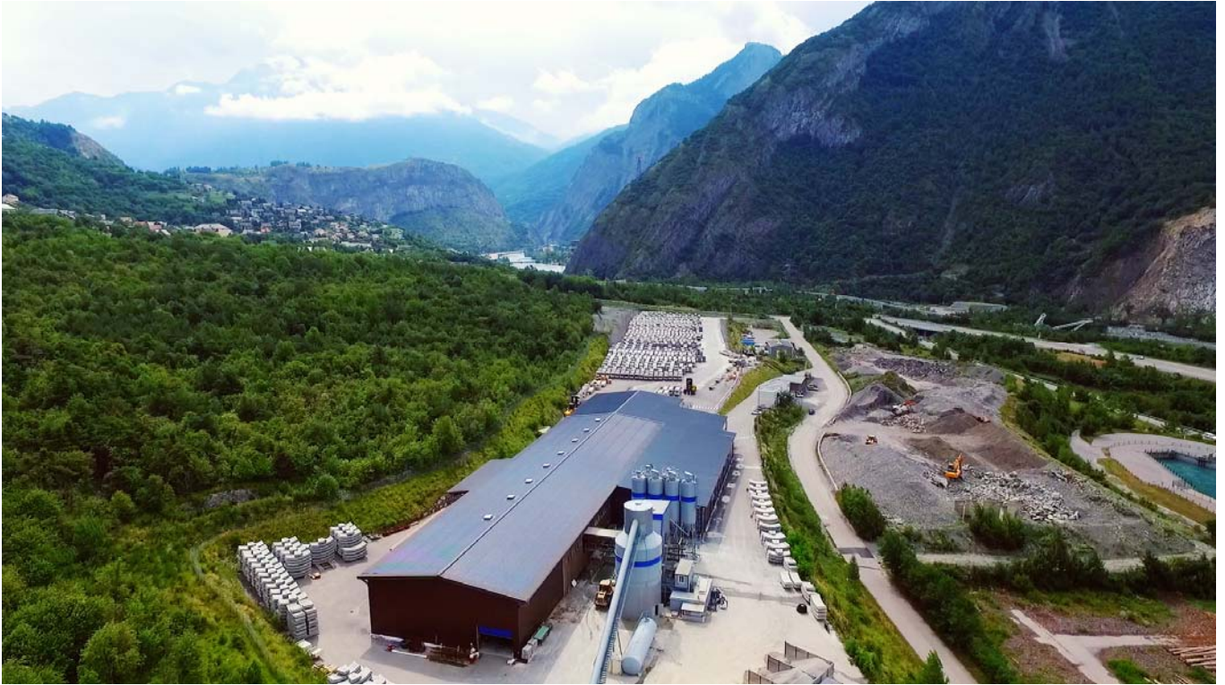
Saint-Martin-La-Porte Usine à voussoirs / Fabbrica di conci
