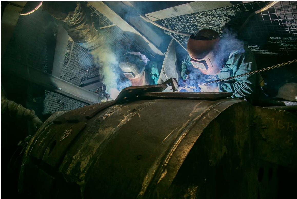
Saint-Martin-La-Porte Maintenance du tunnelier / Manutenzione della fresa
