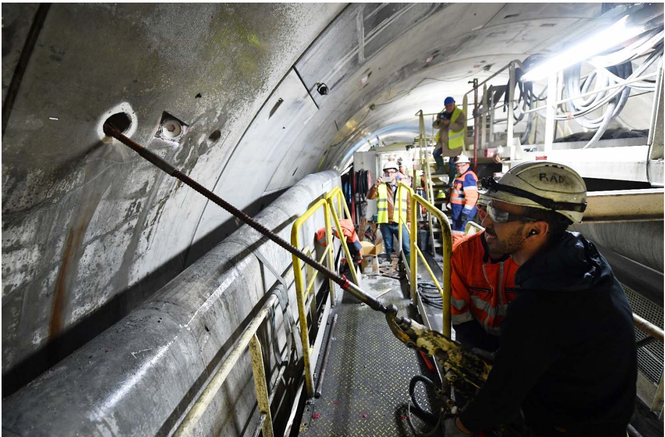
Saint-Martin-La-Porte Injection de résine / introduzione della resina
