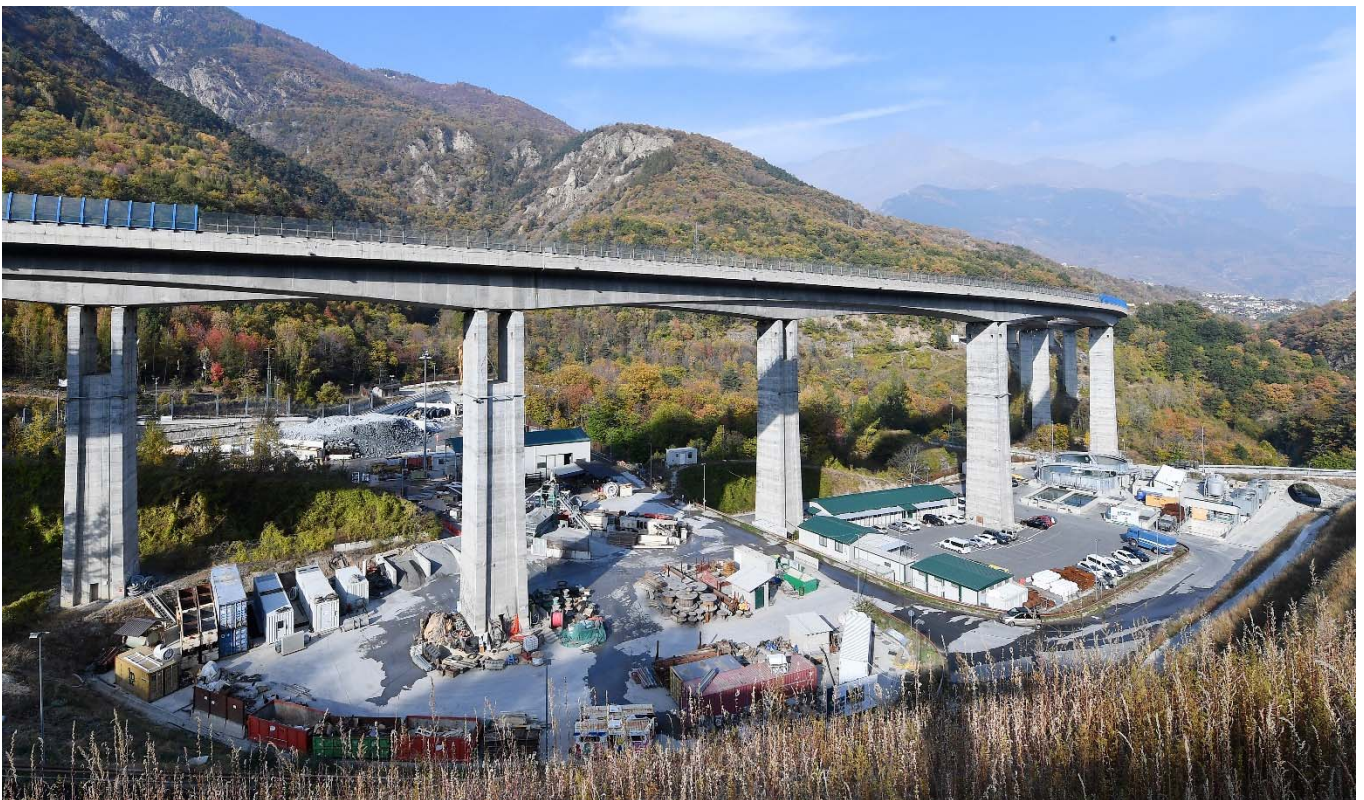
Chantier / Cantiere Chiomonte
