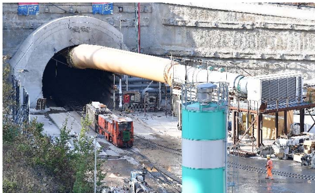
Chiomonte entrée du tunnel / entrata tunnel
