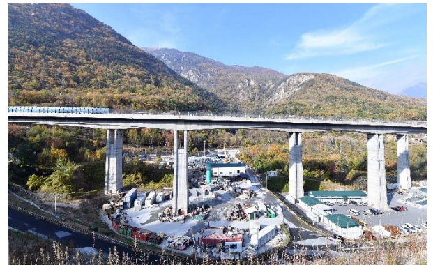
Chiomonte plateforme de chantier / piattaforma del cantiere
